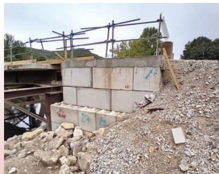
Accès estacade : murs légo dalles béton et remblai
