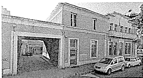
Facade nord-est sur rue V. Hugo
