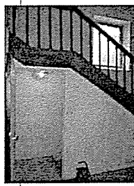
Escalier bois accès étage (Côté ouest) + accès cave en dessous
