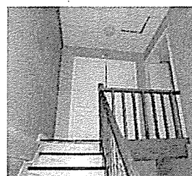
Le palier d'arrivée de l'escalier nord-est
