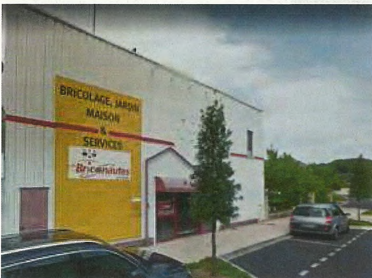
Façade commerciale au n°3 rue du Docteur DUPART Bâtiment destiné à être démolì.
