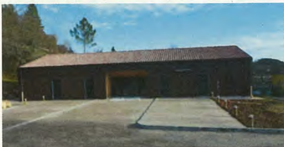
Exemples façades d'entrée : 1 • CMS de Montignac - RK Architecte 2 • CMS de Vergt - B. CHINOIRS
