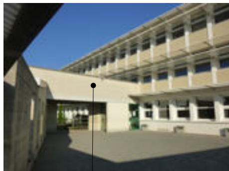
Préau 2 à démolir
