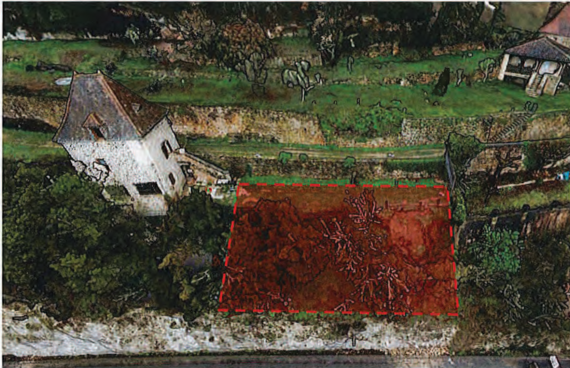
Zone à conforter
