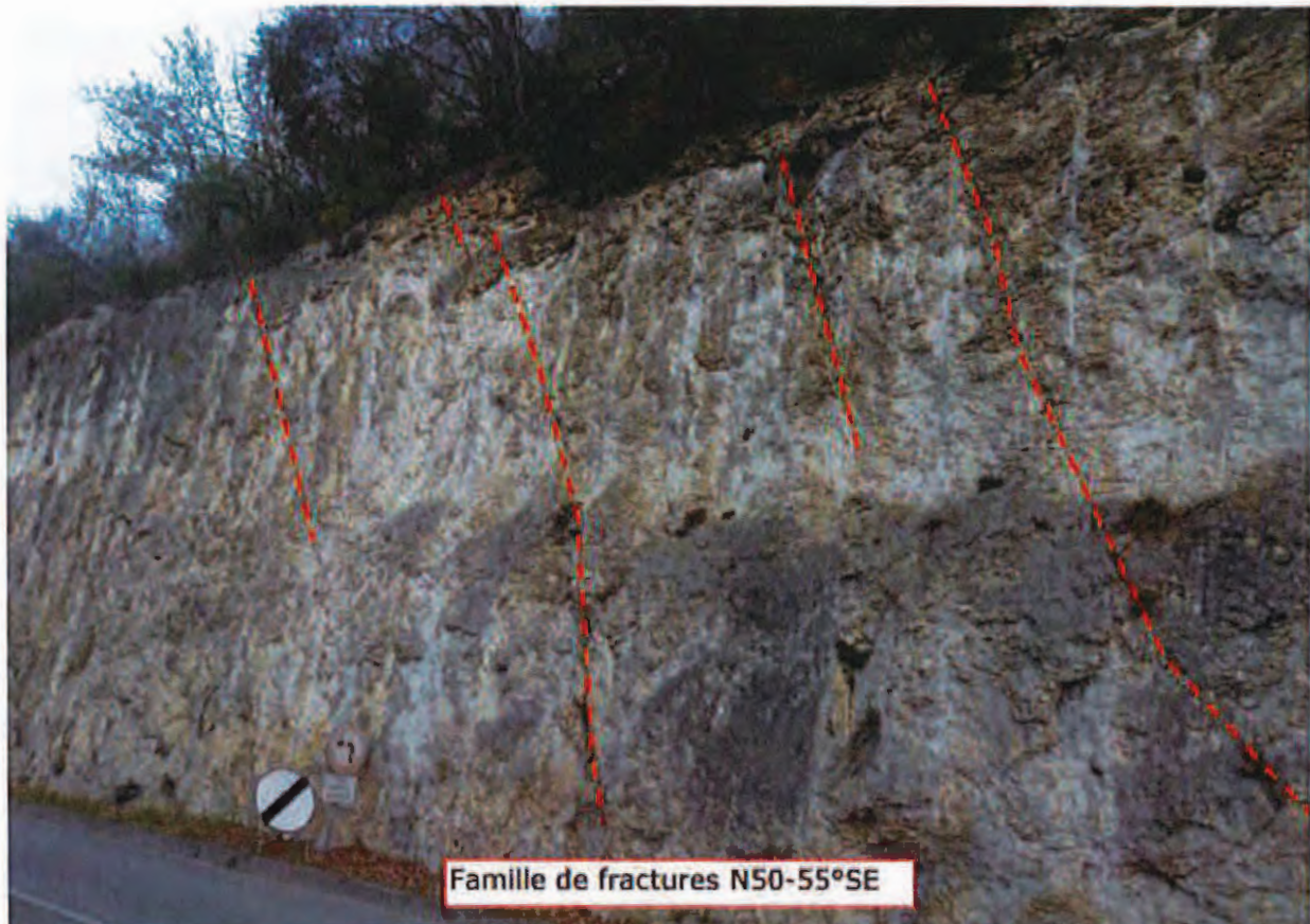
Talus rocheux en partie basse du site
