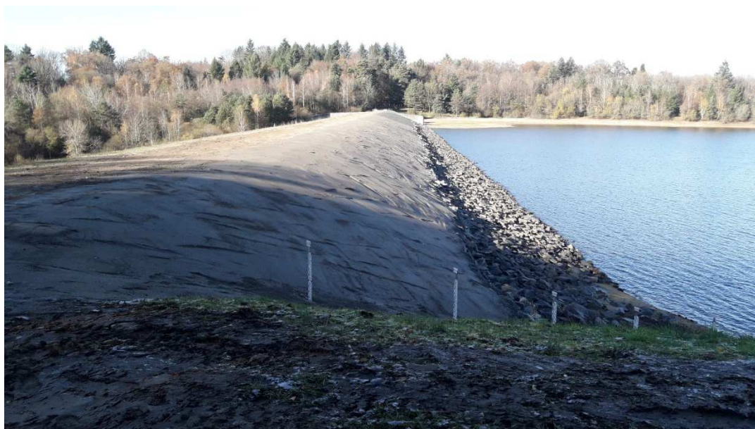
BARRAGE DE MIALLET— PREPARATION DU SOL DU PAREMENT AMONT
