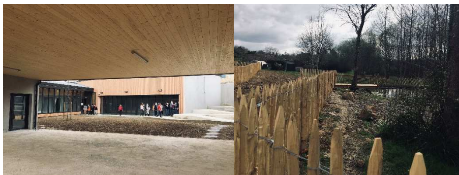
Groupe scolaire de Lembras : Groupe A40 Architectes et Marine Vigier Paysagiste conceptrice
