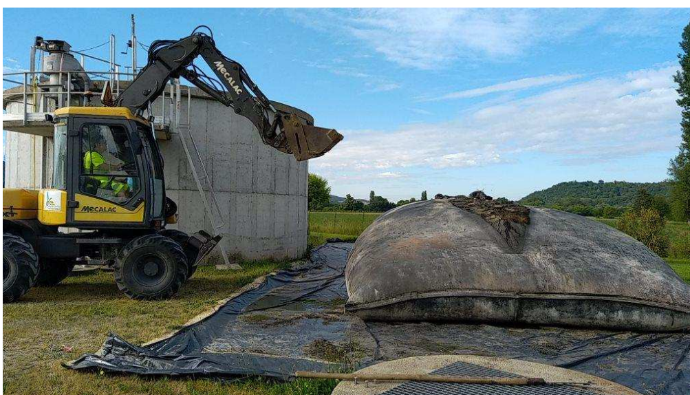
Ouverture d'un géotube (permet épaissement des boues) et vidange des boues
