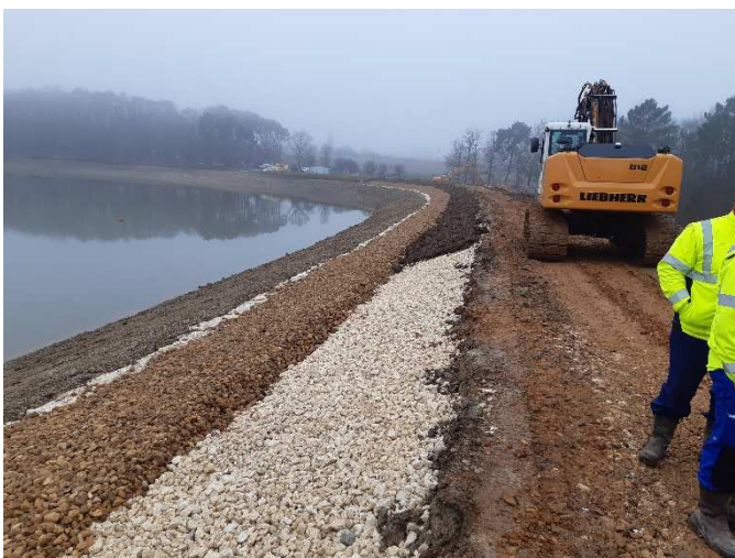
Barrage du Grand étang de Gurson
