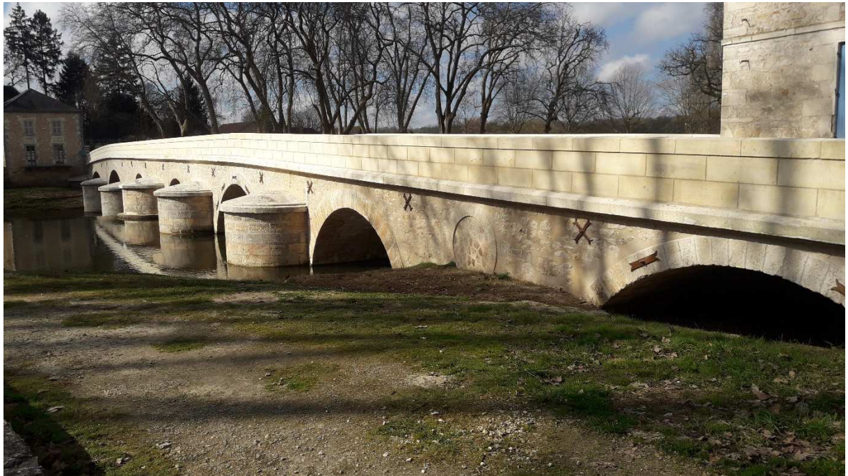
Le Pont de CUBJAC sur la RD 68
