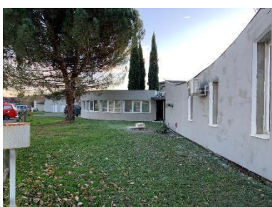
Pose des appuis fenêtre
