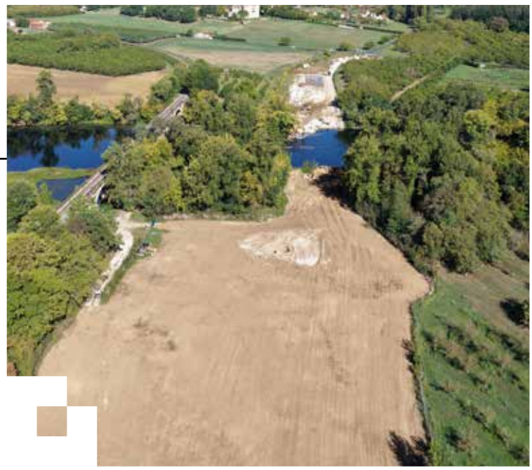
Tous les équipements autorisés sont en cours de démolition
