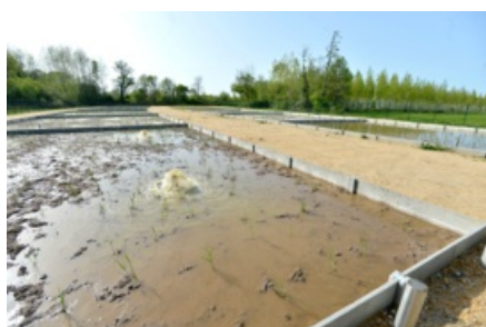
Une station d'épuration avec filtres plantés de roseaux à Saint-Aulaye
